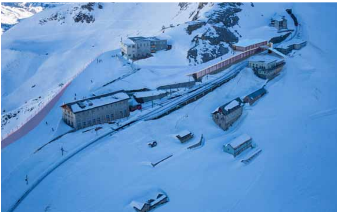
Abb. 7 JB-Station Eigergletscher auf Seite Lauterbrunnen mit neuer Galerie und Pistenverbreiterung beim Werkstattgebäude auf Seite Grindelwald
