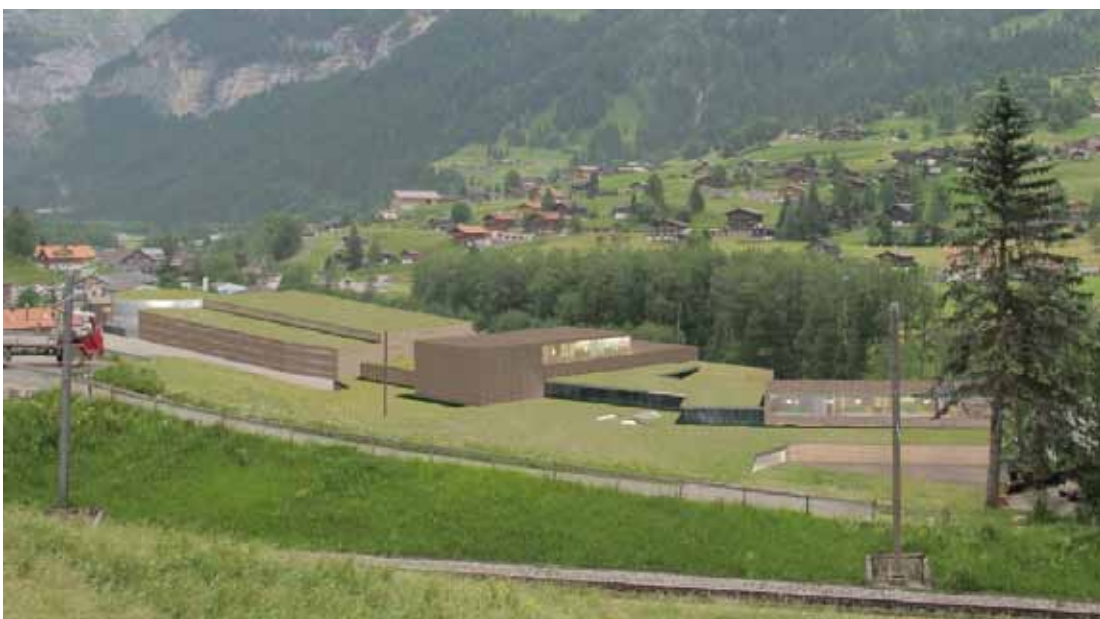
Abb. 18 Dachaufsicht Parkhaus und Talstation Grund mit weitgehend begrüntem Dächern
