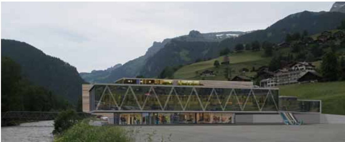
Abb. 3 Talstation Grund, kaum einsehbare Ostfassade gegen Parkhaus Grund, vorgelagert nicht dargestellt soll das Parkhaus erstellt werden
